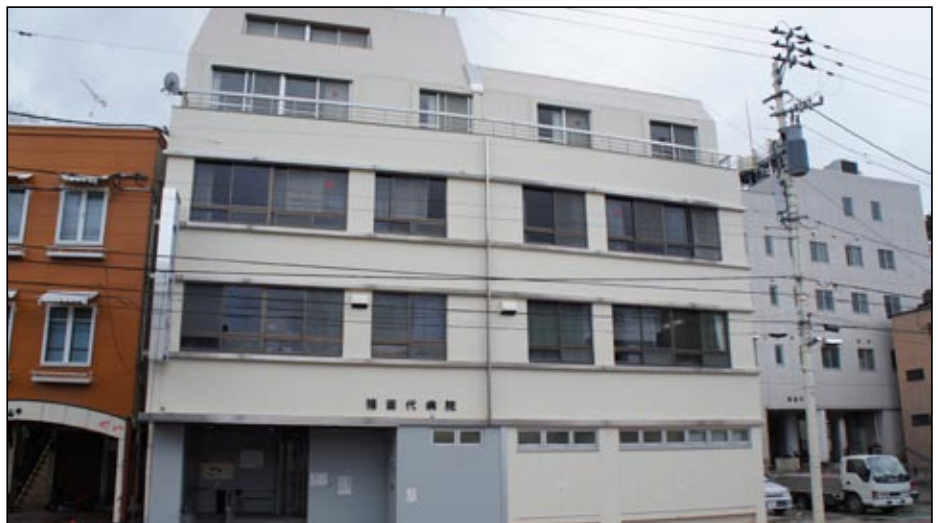
気仙沼の猪苗代病院は、2011年12月に改修工事が完了した。
